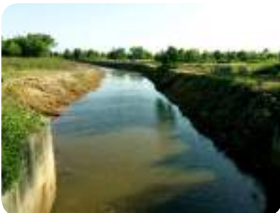
ขุดลอกคู-คลอง เพิ่มศักยภาพการระบายน้ำ
